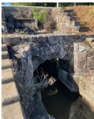
【西奥田樋門 愛知県西尾市】
