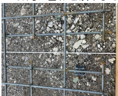
【鉄筋欠損】
